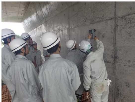
コンクリート構造物の非破壊試験
