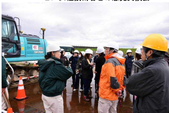
庄川・柳瀬護岸災害復旧 (ICT建機)
