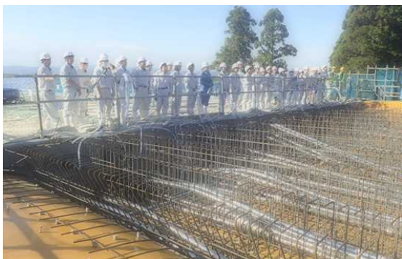
上部工(PC中空床版)の見学
