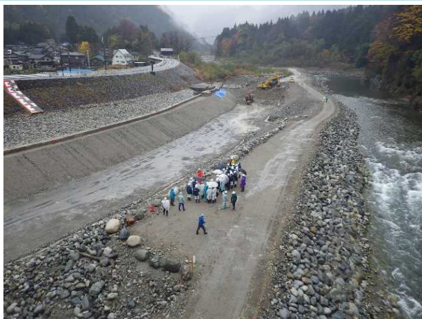
仮締め切り中の現場での説明
