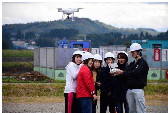
庄川・柳瀬護岸災害復旧 (ドローン)
