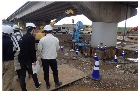
鋼矢板の施工状況見学
