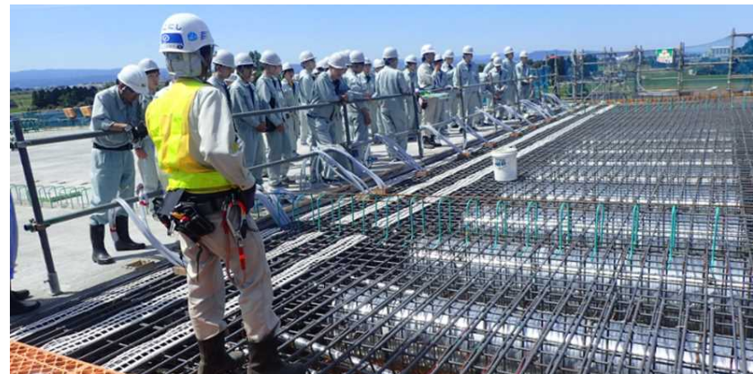
中空床板を視察する参加者(いかるぎの大橋その2工事)
