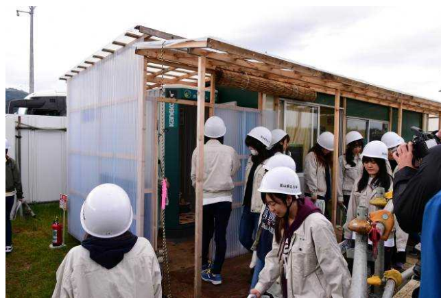
小矢部川・西中野堤防強化工事 (現場事務所)
