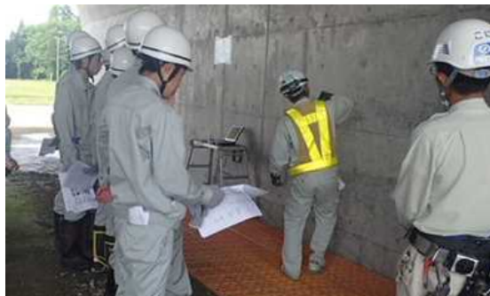
コンクリート構造物の非破壊試験説明
