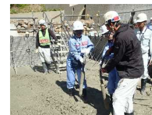
コンクリート打設体験
