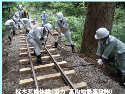
枕木交換体験(協力:富山地鉄建設㈱)
