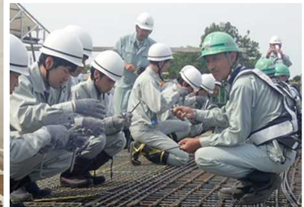
鉄筋組立の体験
