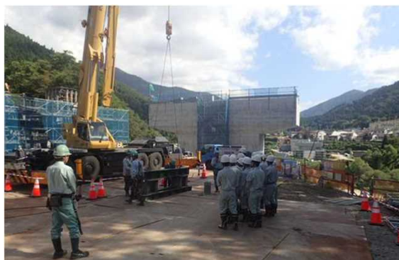
橋梁上部工事の現場見学
